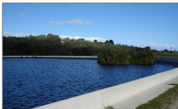
Figura 6. Balsa de almacenamiento de aguas regeneradas de Ariany.
